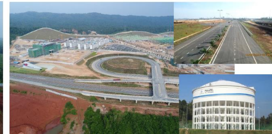
MCKIP Main Road & Infrastructure 主要干道和基础设施
